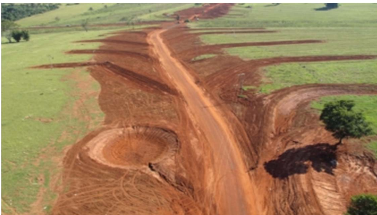
Figura 14. Bacias de contenção em estradas rurais.
