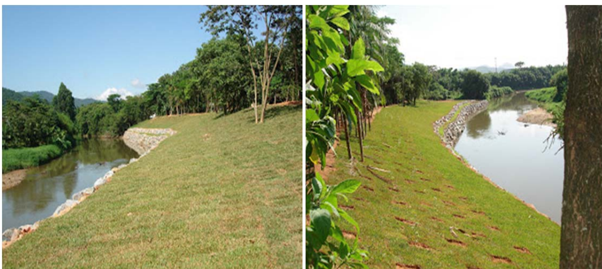
Figura 13. Técnicas de enrocamento.
