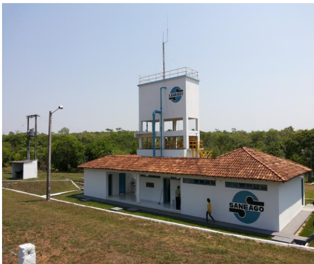
Figura 8– Vista geral da ETA.
