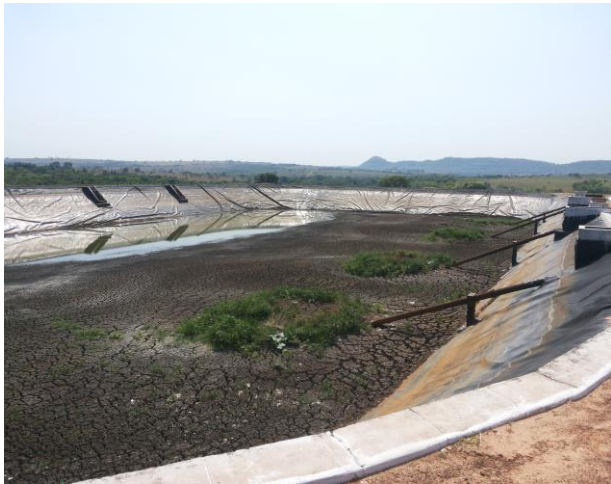
Figura 6– Lagoa Anaeróbia B desativada.
