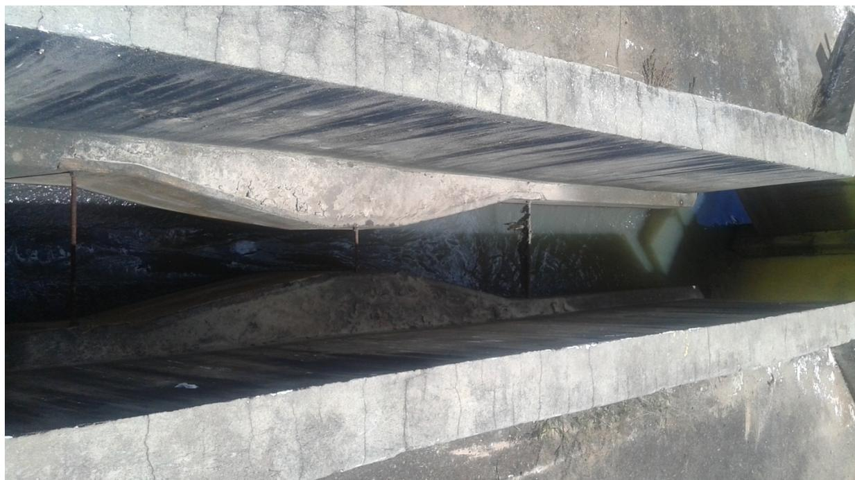
**Foto 16. Calha Parshall - Medidor de Vazão (entrada do efluente) - 25/02/2015.**
