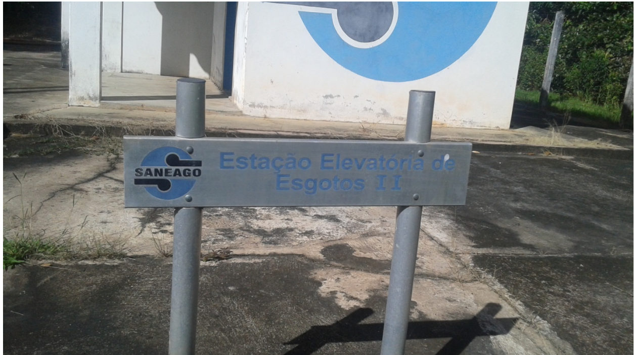
Foto 13. Visita técnica na Estação Elevatória de Esgoto II - 25/02/2015.
