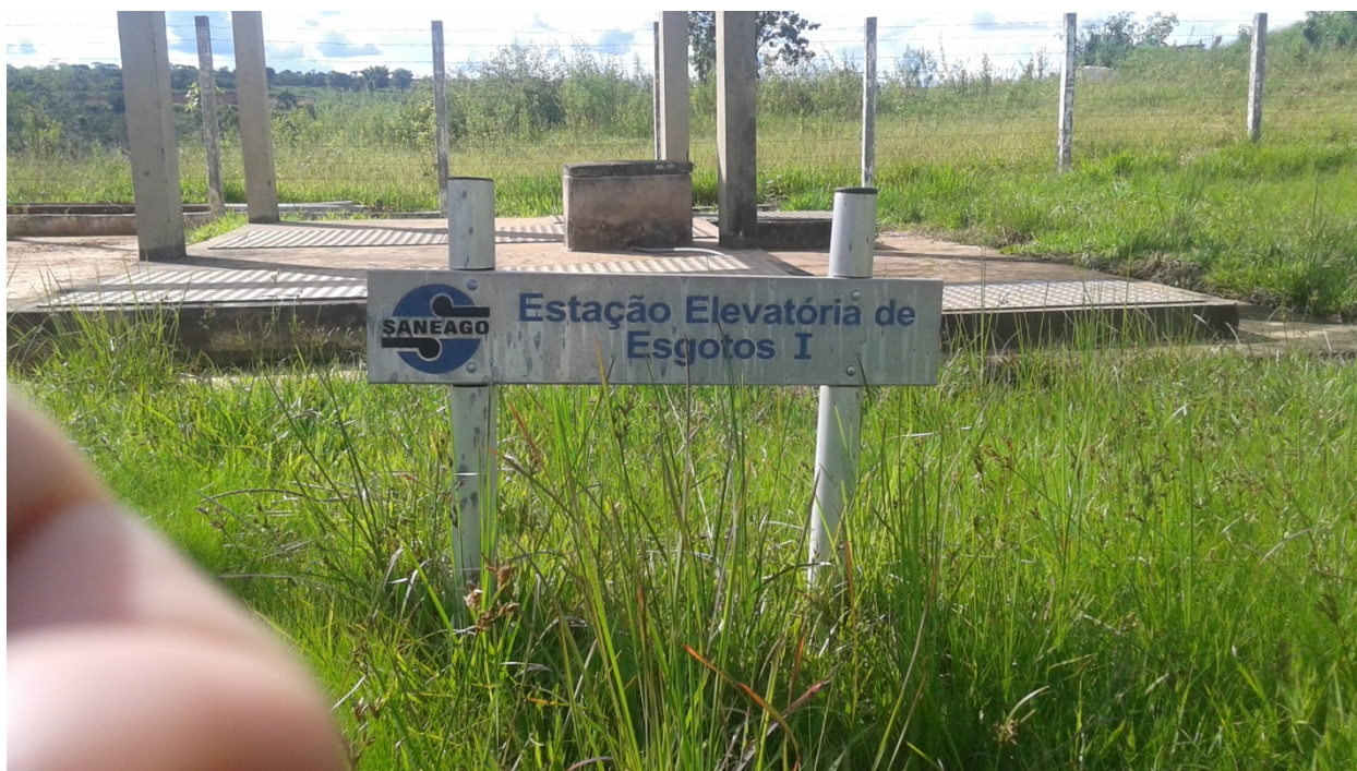
Foto 11. Visita técnica na Estação Elevatória de Esgoto I - 25/02/2015.
