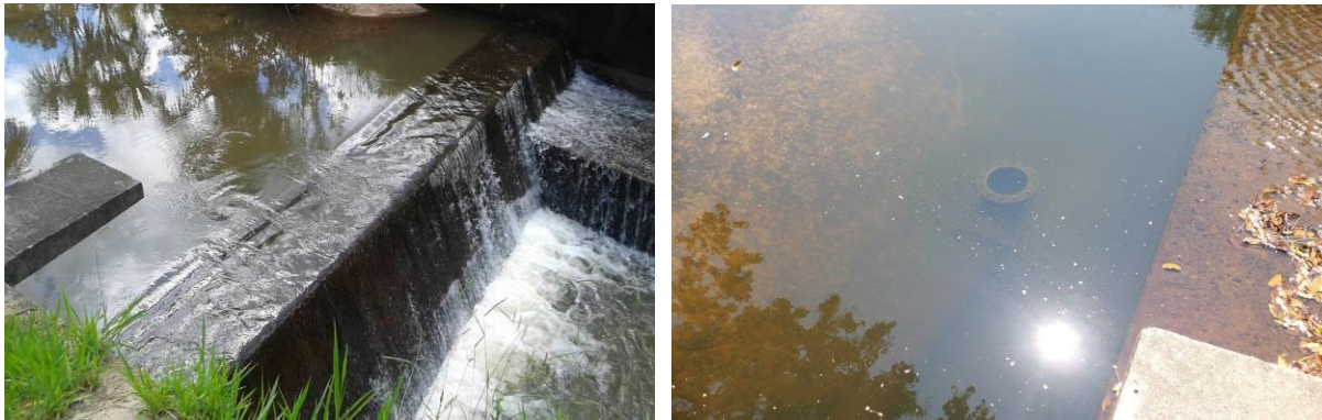
Figura 26. Estrutura de captação – Barragem e Tubulação de captação. Fonte: TERRA Consultoria, Estudos e Projetos Ambientais, 2015.
