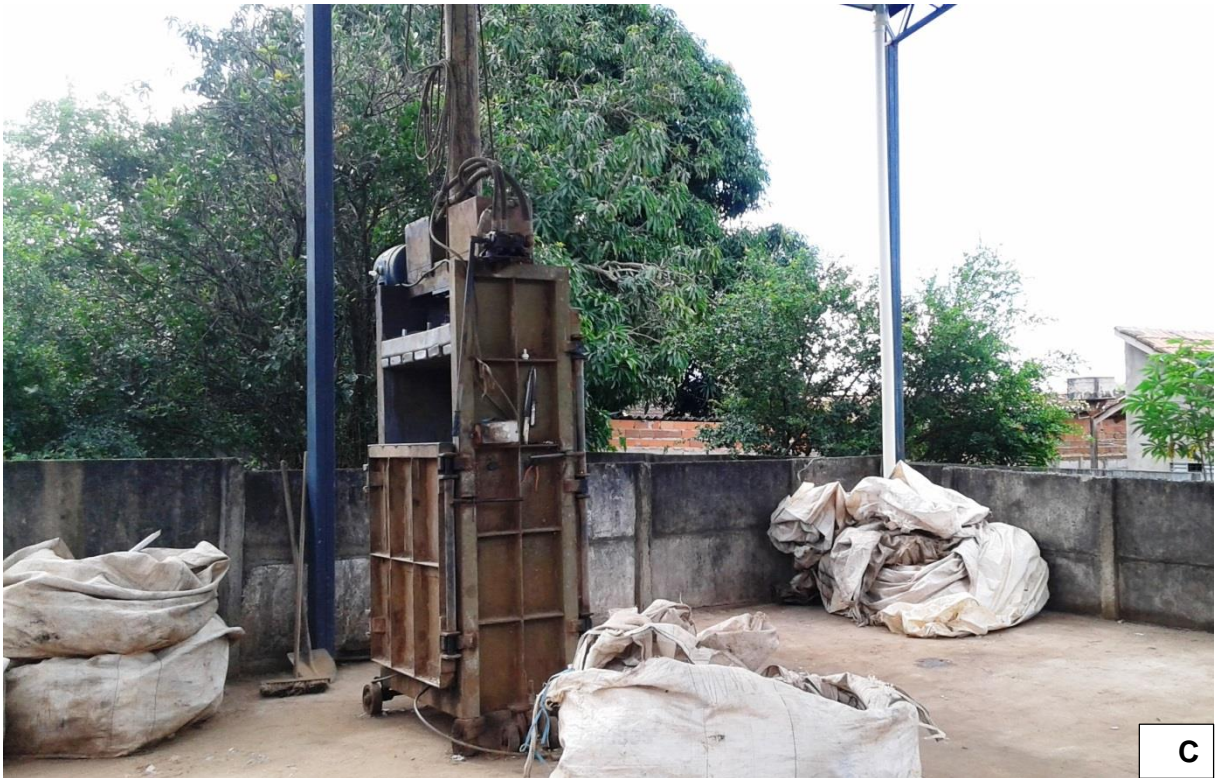
Figura 112. Metais compactados (A), papelão compactado (B) e prensa (C). Fonte: TERRA Consultoria, Estudos e Projetos Ambientais, 2015.
