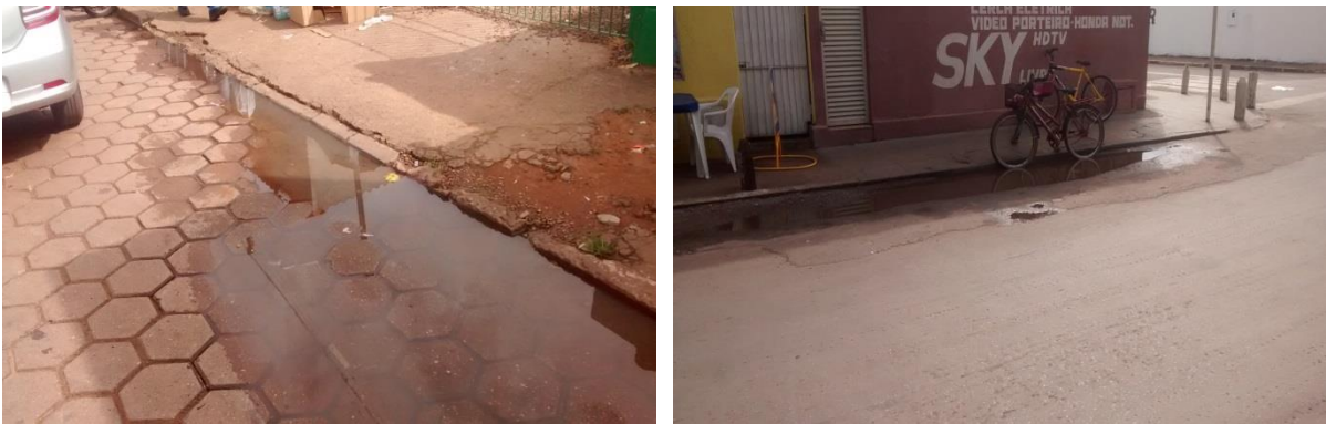
Figura 81. Empoçamento de água nas vias – Av. do Comércio e Av. Cel. Lindolfo A. Dias. Fonte: TERRA Consultoria, Estudos e Projetos Ambientais, 2015.
