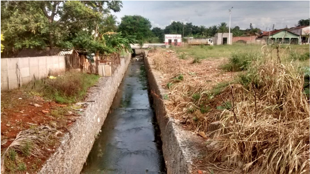
Figura 78. Vista de parte do trecho canalizado – Rua José Amâncio de Souza com a Rua 15. Fonte: TERRA Consultoria, Estudos e Projetos Ambientais, 2015.
