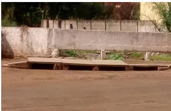
Figura 75. Bocas de lobo localizadas, respectivamente, na Av. Plínio Gayer e Av. Mário J. Vilela. Fonte: TERRA Consultoria, Estudos e Projetos Ambientais, 2015.
