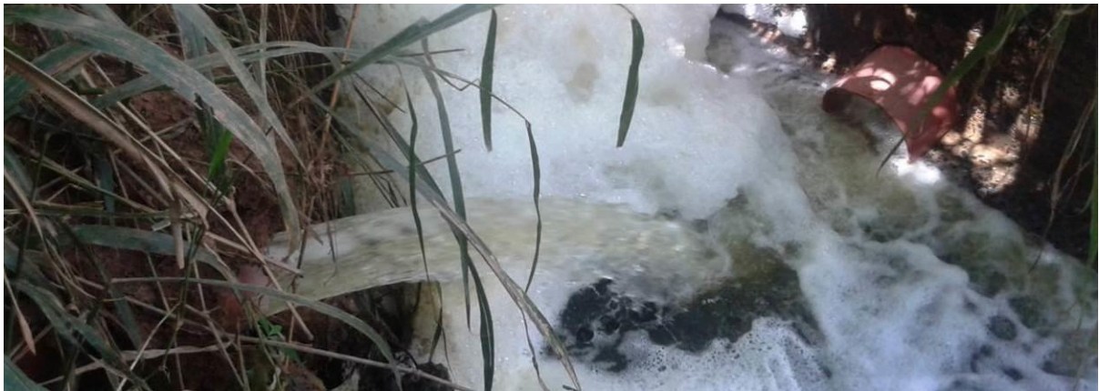
Figura 66. Espuma no lançamento do efluente tratado da ETE. Fonte: TERRA Consultoria, Estudos e Projetos Ambientais, 2015.
