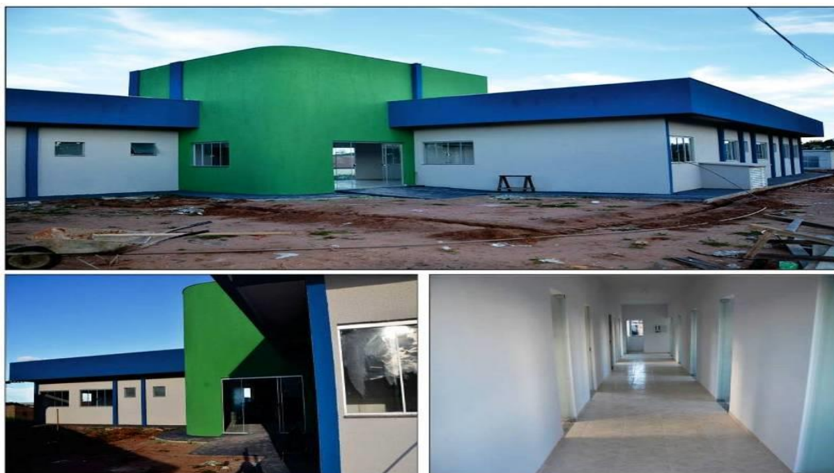
Figura 5. Construção da nova UBS. Fonte: Facebook da Secretaria de Saúde de Caiapônia, 2015.
