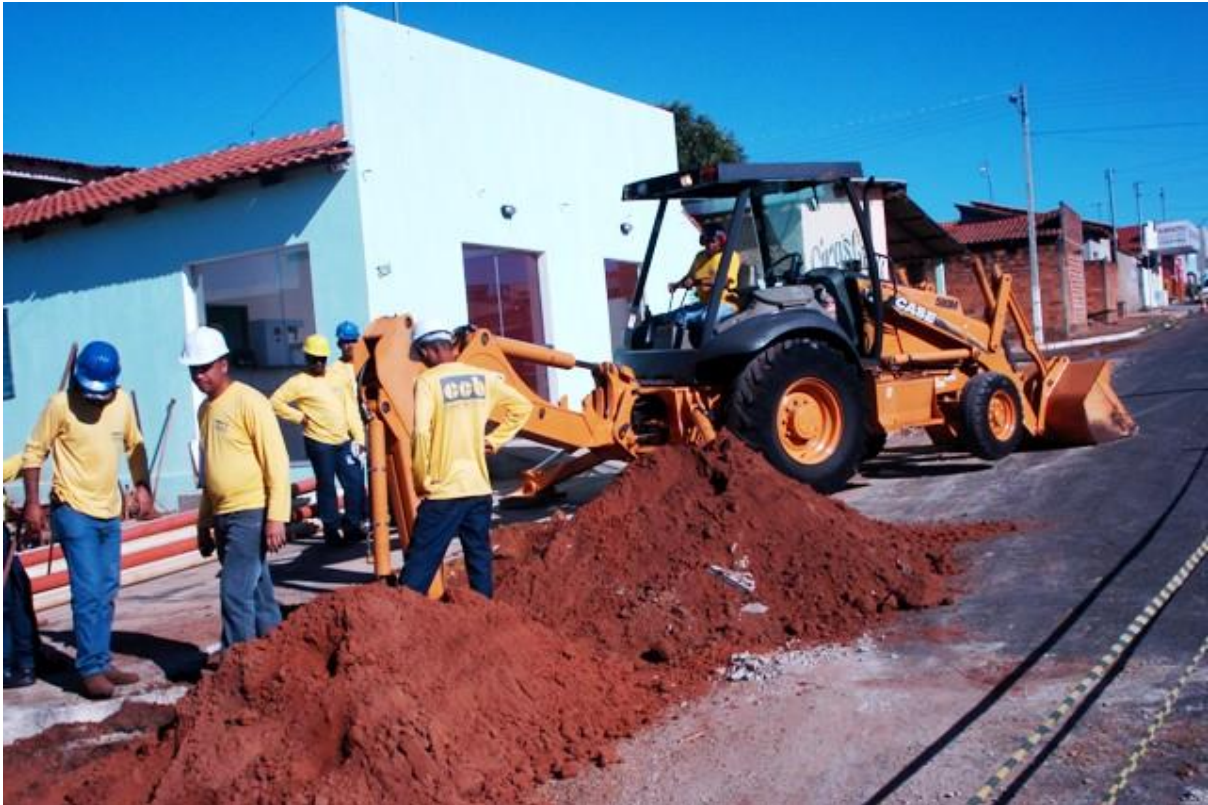
Figura 63. Ampliação da rede coletora de esgoto. Fonte: Prefeitura Municipal de Caiapônia, 2015.
