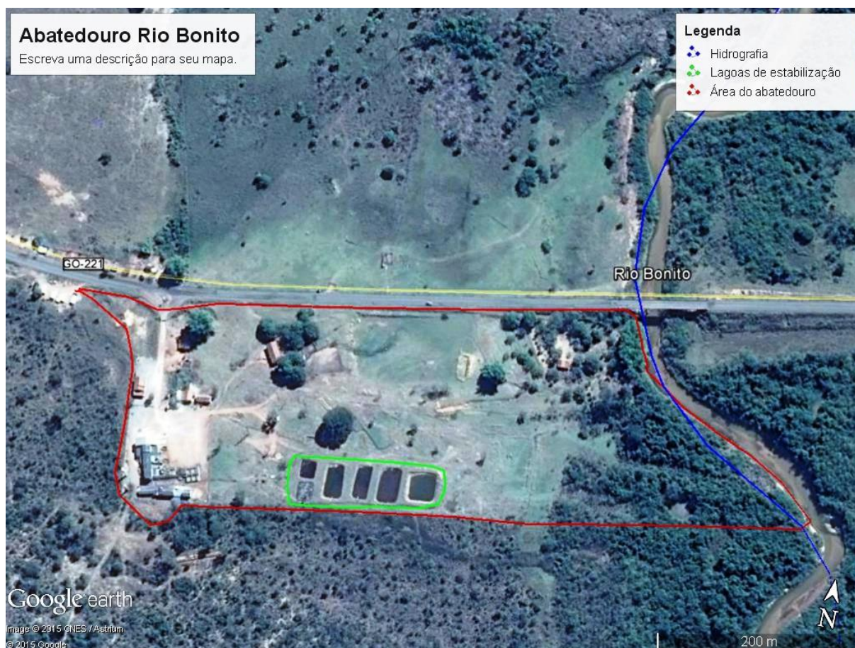
Figura 62. ETE do Abatedouro Rio Bonito.
