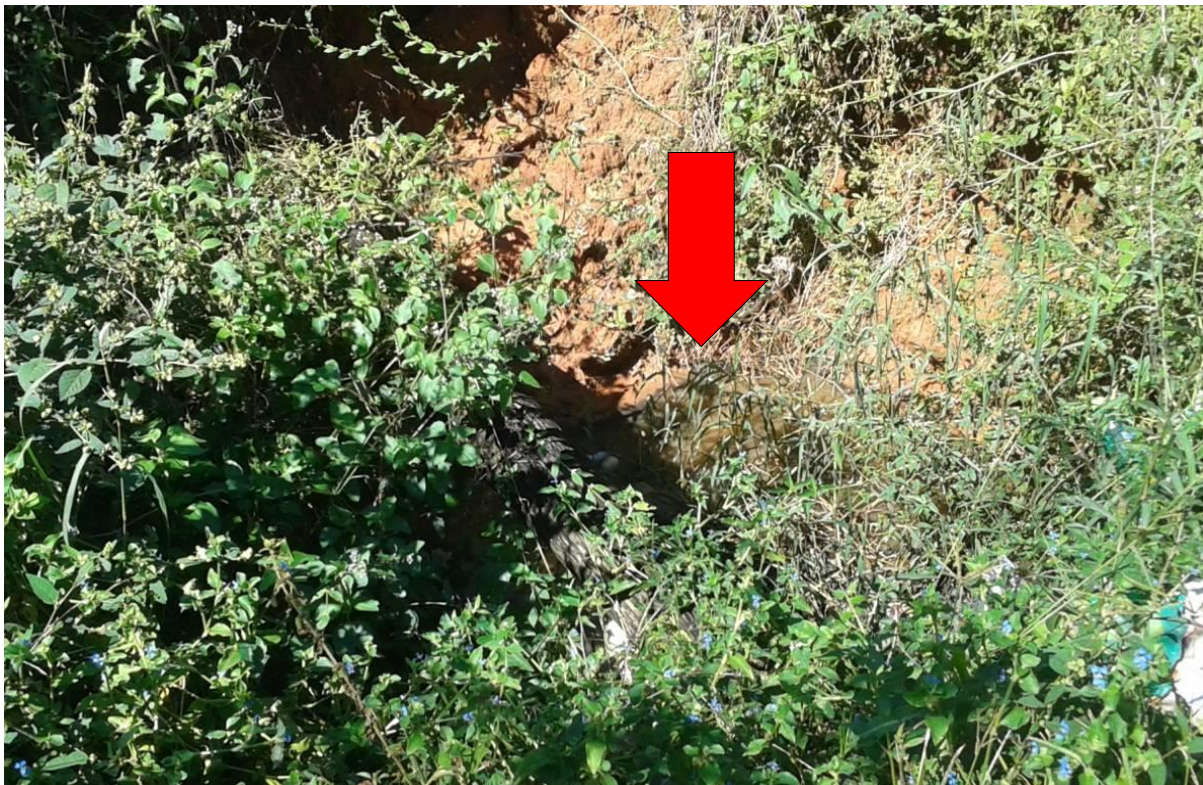
Figura 61. Esgoto in natura no Assentamento Cachoeira Bonita. Fonte: TERRA Consultoria, Estudos e Projetos Ambientais, 2015.
