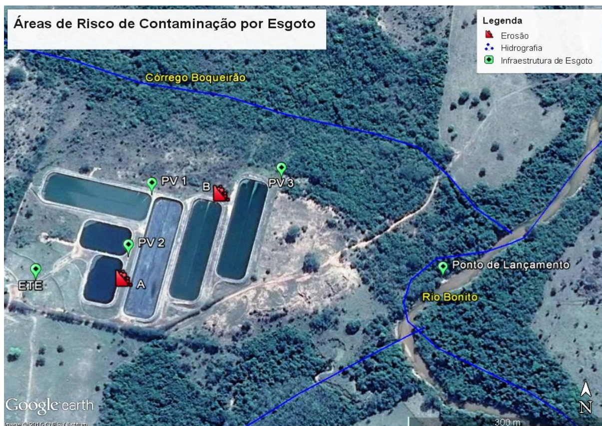
Figura 60. Risco de contaminação por esgoto.
