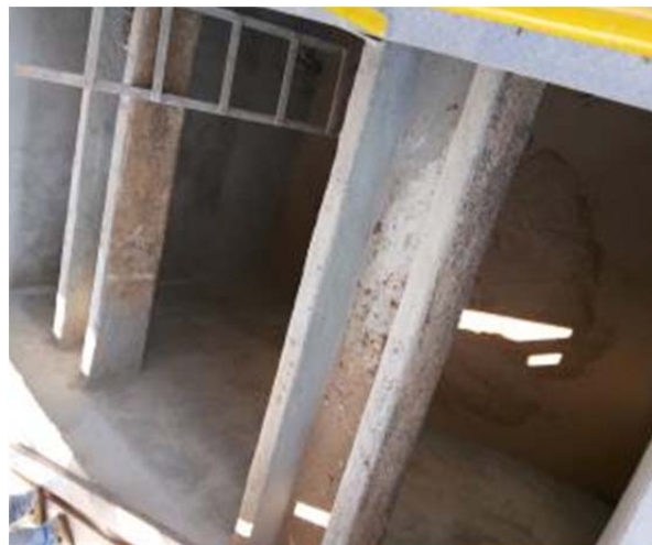
Figura 113. Filtros passando por manutenção.
