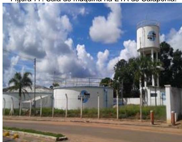
Figura 79. Vista geral do centro de reservação de Caiapônia.
