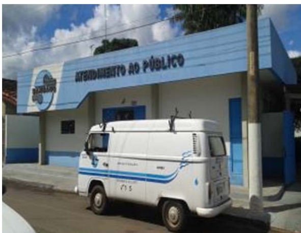
Figura 76. Sede da SANEAGO em Caiapônia.
