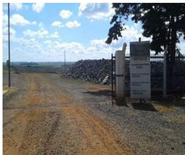
Figura 93. Mineradora de Calcário - Caiapônia.
