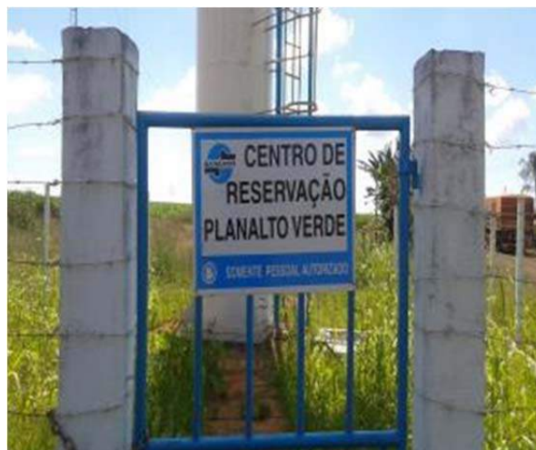
Figura 91. Centro de reservação - Planalto Verde.
