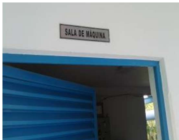
Figura 77. Sala de máquina na ETA de Caiapônia.
