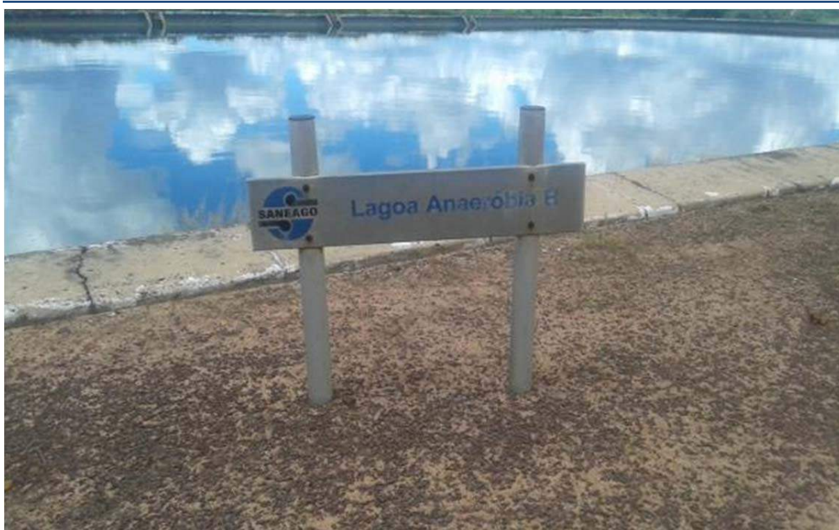
Figura 68. Lagoa Anaeróbia B - 25/02/2015.
