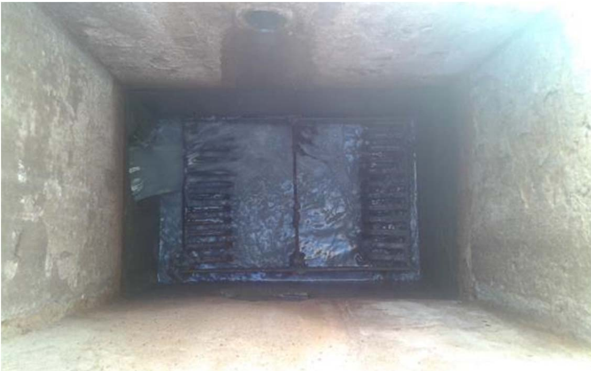
Figura 62. Ponto de recebimento do efluente (gradeamento) - 25/02/2015.
