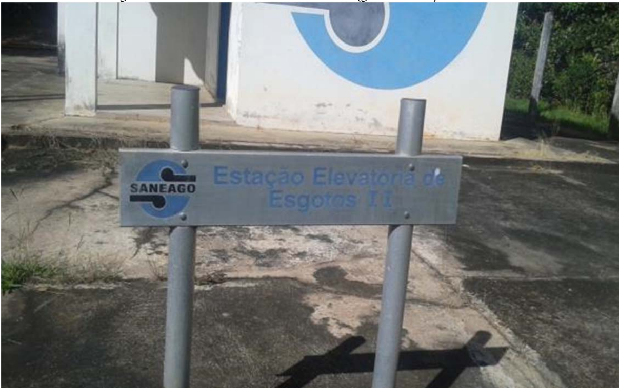
Figura 63. Visita técnica na Estação Elevatória de Esgoto II - 25/02/2015.
